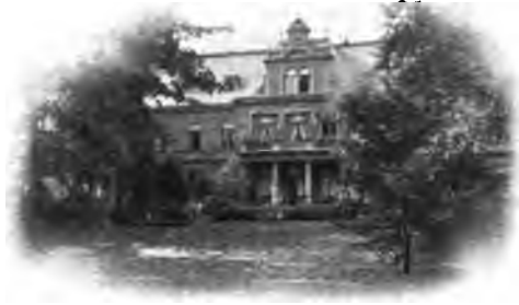
Abb. 157. Villa Oppenheim, Scharrenstraße Nr. 23—27.
